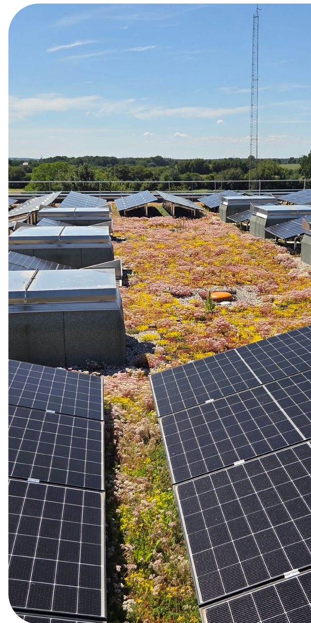
PV-Anlagen auf dem Gründach der Block Menü
